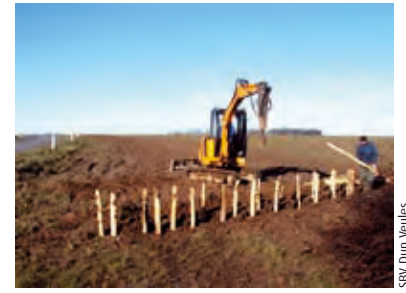
Battage des pieux
