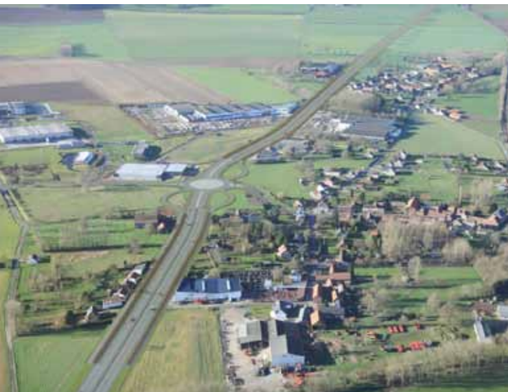
Avant/Après traversée de Tincques
