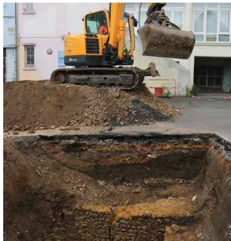
Les murs d'une bâtisse en pierre médiévale mis au jour en 2020 durant le diagnostic de la MDS de Saint-Pol.
