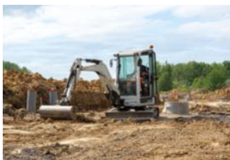
25 mai 2022 ZAC du Chemin de l'Abbaye à Vendin les Béthune – Démarrage de la première phase de viabilisation
