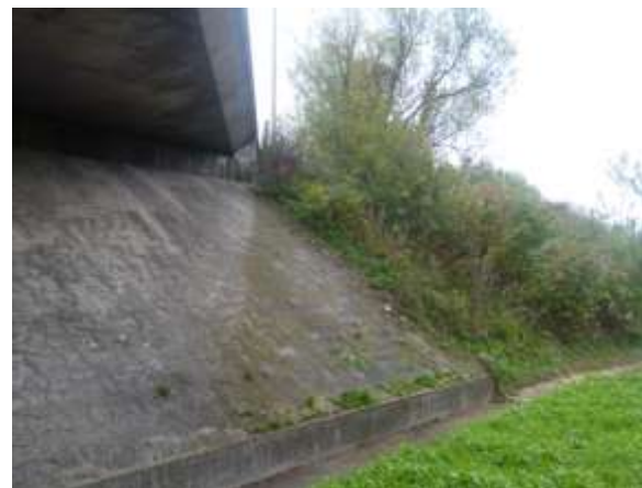
Photo n°3-Vue des perrés depuis l'A26 côté LENS
